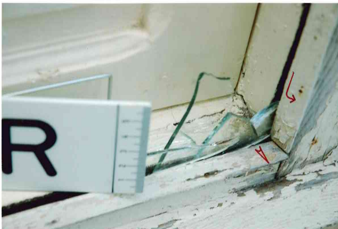
Foto n. 17 : .....particolare della divaricazione della canalizzazione dove era alloggiato il vetro.
