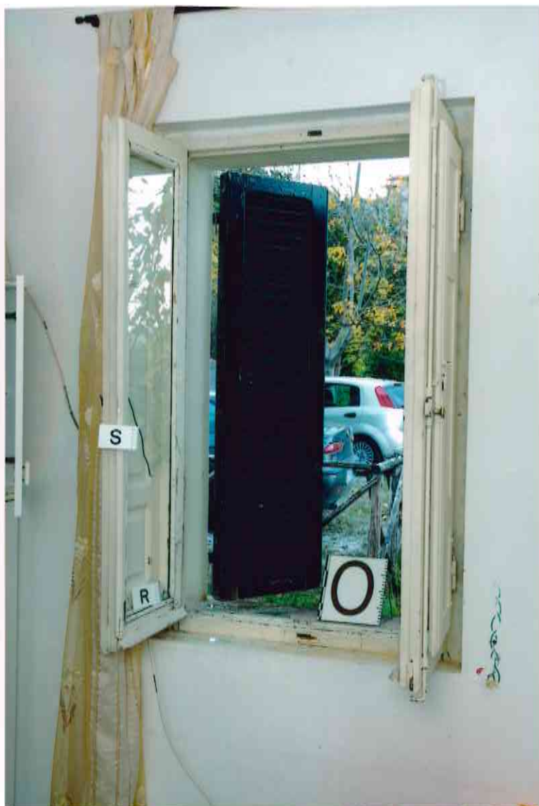
Foto dalla n. 11 alla n. 12 Condizioni dell'interno della camera di Romanelli Filomena documentate nelle foto della polizia Scientifica eseguite in data 02 novembre 2007. Parete anteriore, particolare della finestra con vetro infranto, distribuzione del vetro sul davanzale esterno ed interno.
