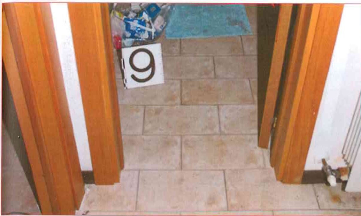
Fig.33 Il tratto di pavimentazione del bagno antistante la porta d'ingresso
