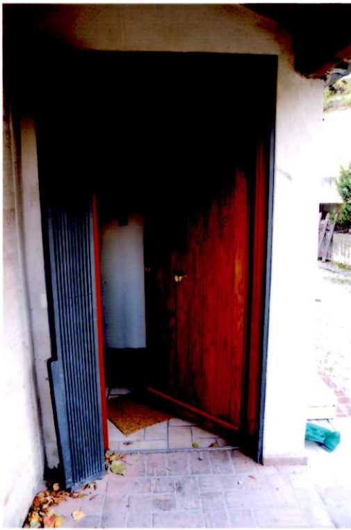
Ingresso e disimpegno - 1
